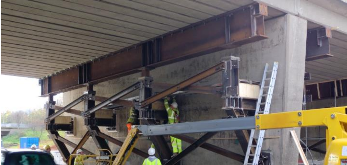
Mynd 19 - frá Freyssinet, dæmi um útbúnað við útskipti á legum
